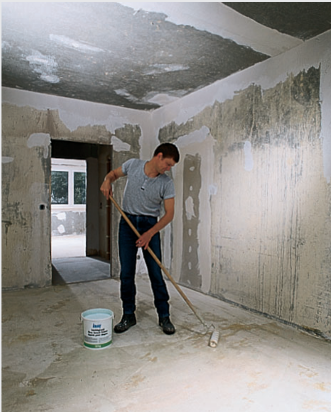
z. B. Grundierung mit Estrichgrund
