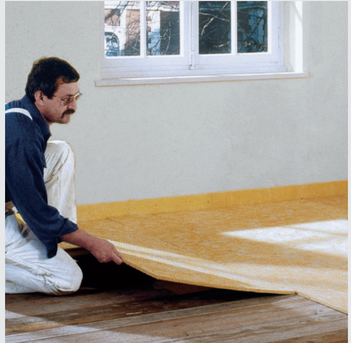
Mineralwolle-Dämmung dicht mit dem Randdämmstreifen stoßen und Reihe für Reihe im Verband verlegen
