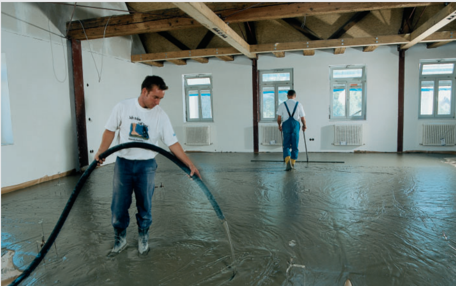
Wo früher aufwendig Styropor gestückelt wurde schließt Knauf Schubo heute fließend alle Hohlräume
