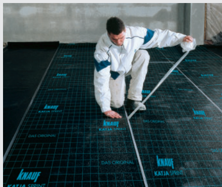
Schließen der Längsstöße durch Abziehen der Schutzfolie
