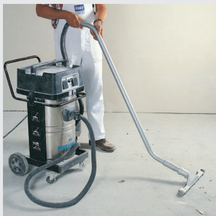
Reinigung mit Industriesauger
