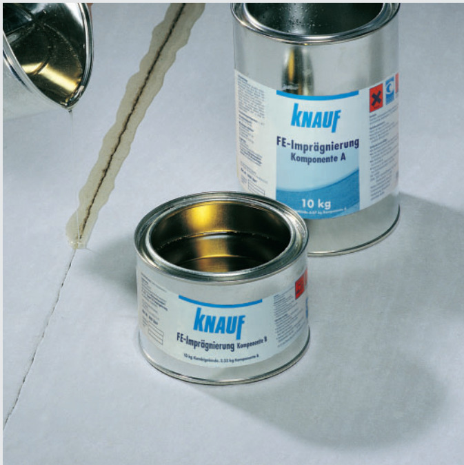
Verharzung von Rissen mit Epoxidharz
