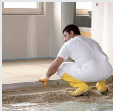
Einbringen mit Druckluftförderer
