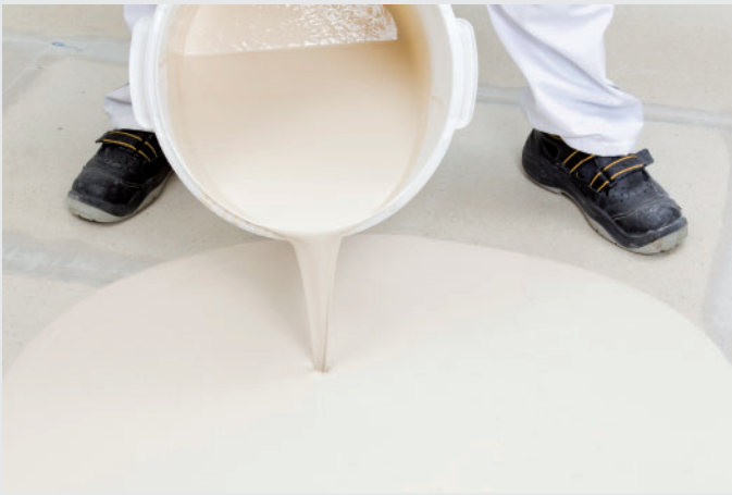
Spachteln des Estrichs mit Knauf Nivellierspachtel 415
