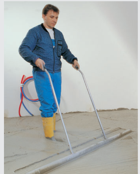
Nach Einbringen des Materials einfach mit der Schwabbelstange eibnen
