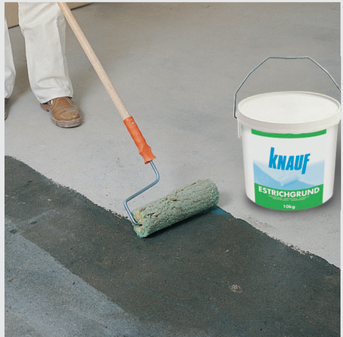
Auftragen von Knauf Estrichgrund
