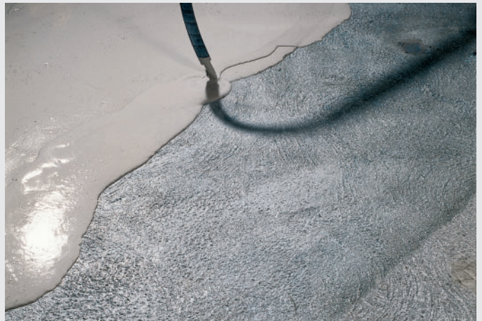
Maschinelles Einbringen von Knauf Nivellierspachtel 415
