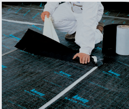
Abdichten von Kopfstößen mit Knauf Anschlussstreifen
