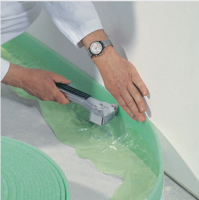
Randdämmstreifen mit Folie anbringen (auch an Rohren, Heizungsständern u. Ä.), nicht in Höhe des Estrichs klammern!
