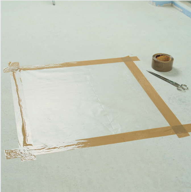
Prüfung der Trocknung mit Folie auf Heizestrich
