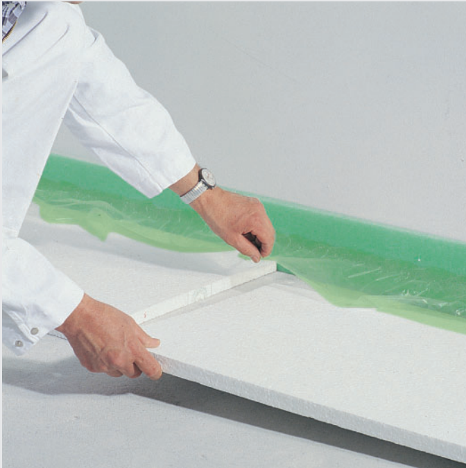
EPS-Dämmung unter die Folie des Randdämmstreifens schieben und Reihe für Reihe im Verband verlegen
