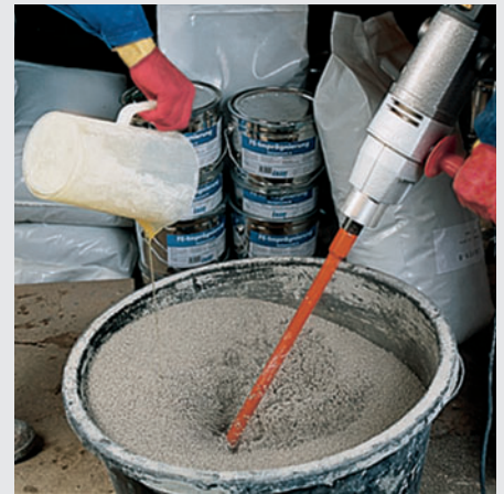
Das Mischen im Bottich erfolgt schnell und ohne großen Kraftaufwand
