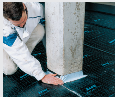
Anschlüsse an aufgehende Bauteile mit Knauf Anschlussstreifen
