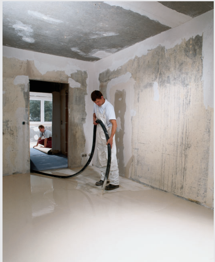
z. B. maschineller Einbau Knauf Nivellierestrich 425
