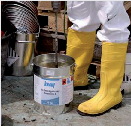
Anmischen des Epoxidharzes mit dem Rührgerät
