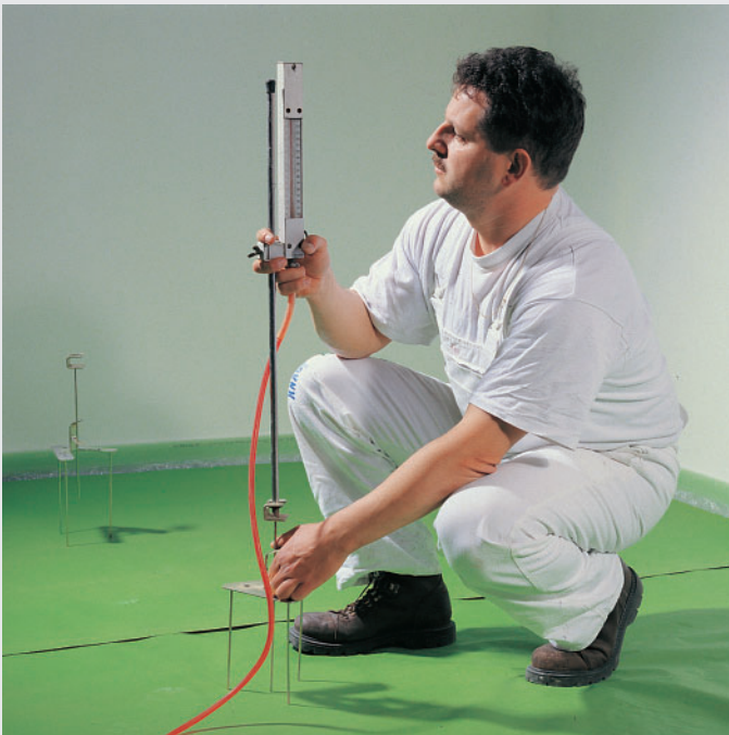
Einstellen der Höhe mit PFT Nivelliertaster
