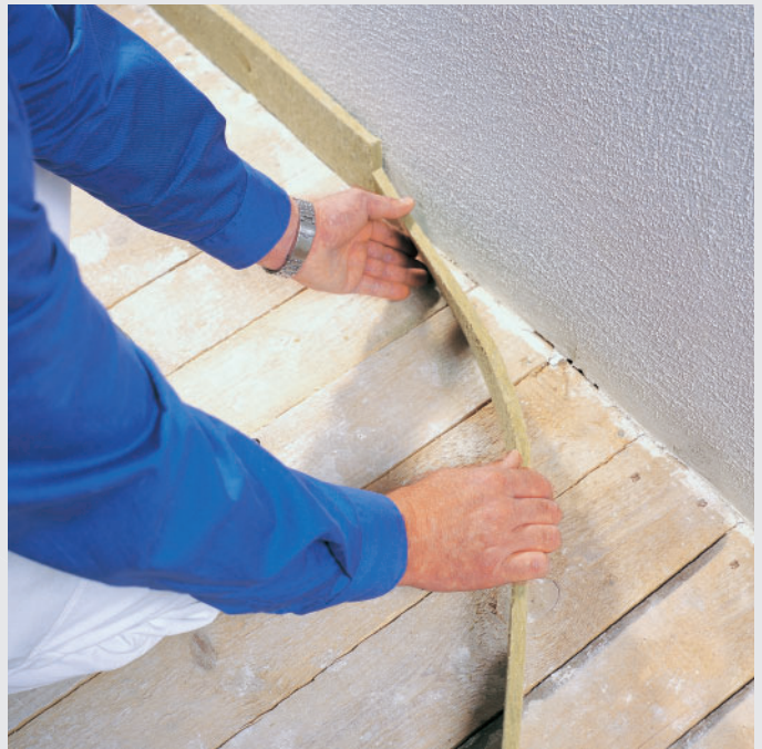
Verlegung Mineralwolle-Randdämmstreifen bei Anforderungen an den Brandschutz
