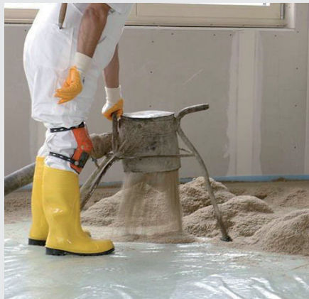
Einbringen mit Druckluftförderer
