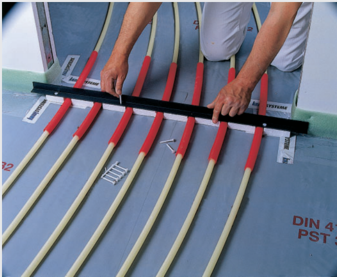
Bewegungsfuge in einem Heizestrich, Bauart A, am Türdurchgang
